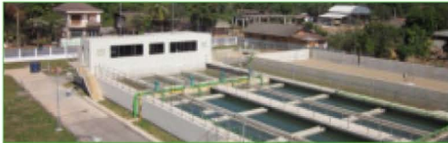
プラント電気、計装設備、設計、施工
